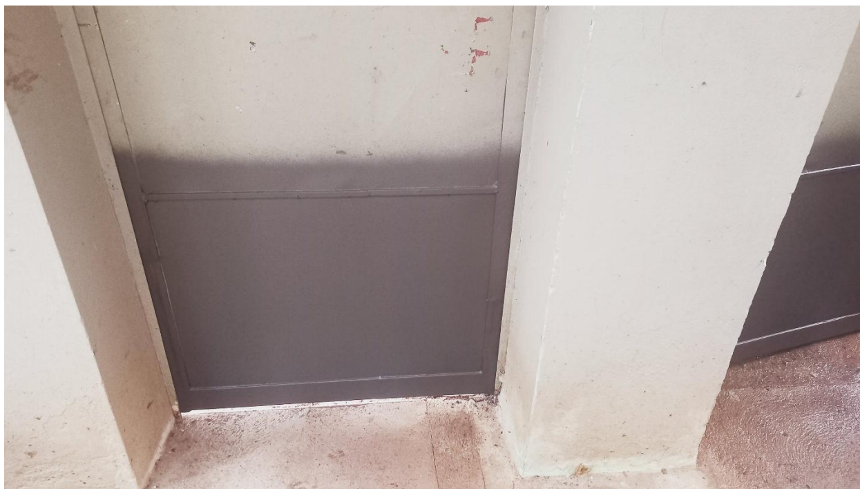
FOTOS 21 e 22 – Reforma de 2 portões dos recintos dos bugios em 25/02/2025.
