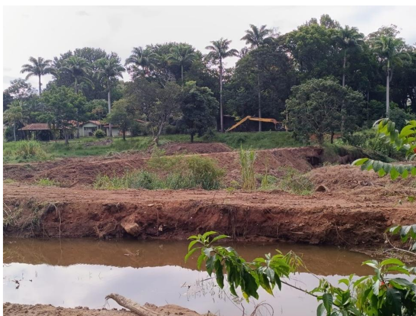
FOTOS 18,19,20,21,22 e 23 – Desassoreamento do lago e desvio do córrego.
